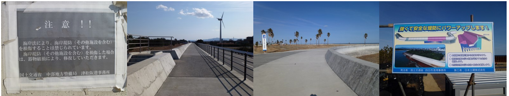
・直轄海岸整備中 > 栗真町屋工区
